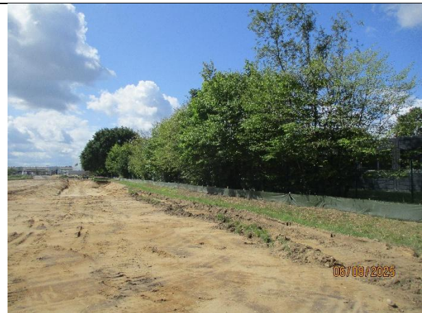
Abb. 8 abgeschobene Bautrasse im östlicher Teilbereich des Plangebietes
