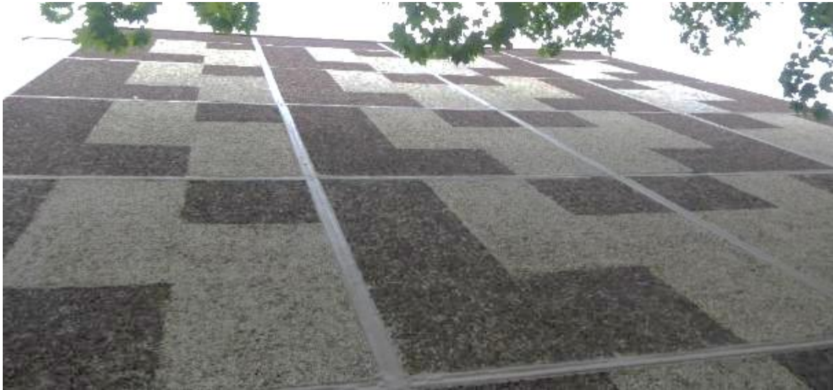
Abbildung 18: Nordfassade des Bestandsgebäudes Damsdorfer Heide
